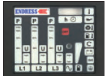
Многофункциональный контрольный дисплей E-MCS 3.0 Изображает текущие важнейшие измеренные значения для электрогенератора.
